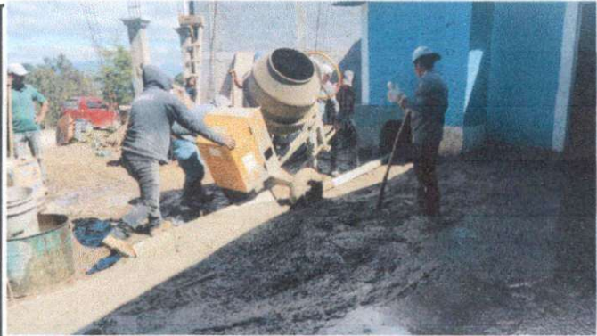
Foto 3: Sustitución de piso torta de cemento
