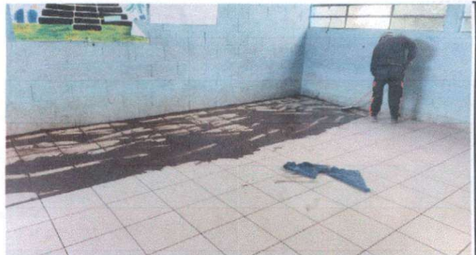
Foto 2: Sustitución de piso cerámico
