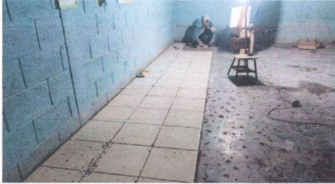
Foto 1: Sustitución de piso cerámico
